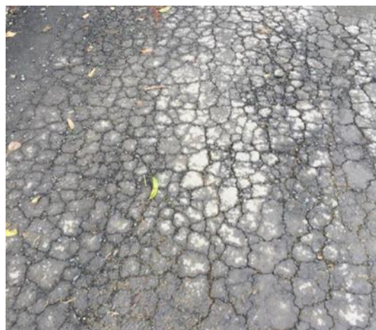
Gambar 7. Retak Kulit Buaya
