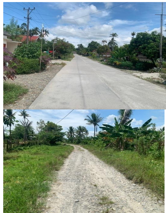
Gambar 2. Kondisi Prasarana Dasar (Jalan)
