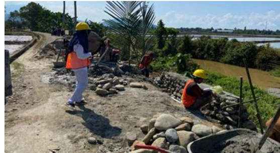
Gambar 4. Pembuatan talud
