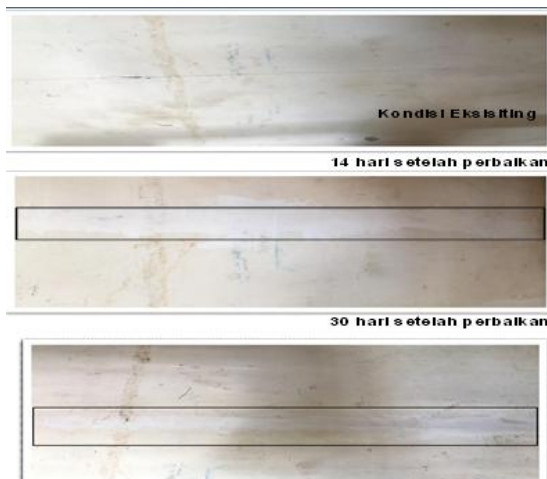
Gambar 6. Kondisi Keretakan Pada Titik 5
