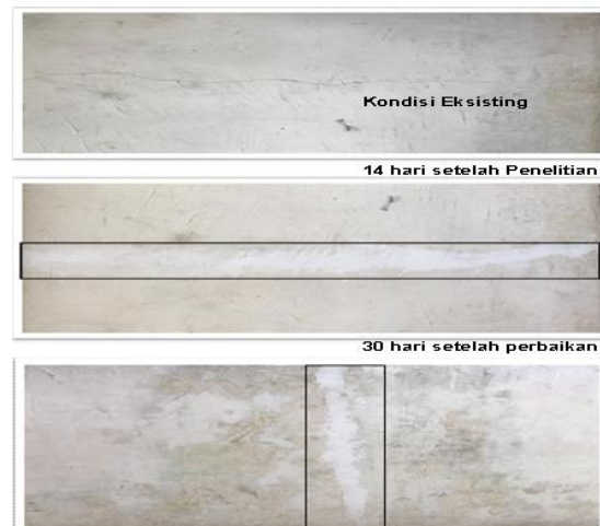
Gambar 5. Kondisi Keretakan Pada Titik 4
