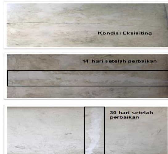
Gambar 3. Kondisi Keretakan Pada Titik 3
