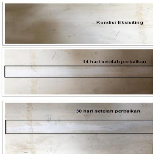
Gambar 2. Kondisi Keretakan Pada Titik 1
