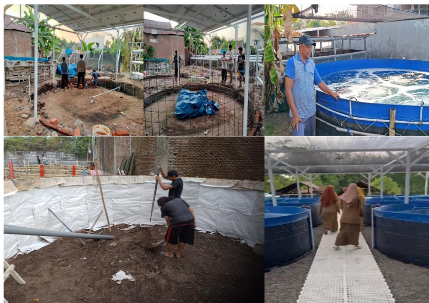
Gambar 3. Pembuatan Kolam Terpal Untuk Budidaya Udang Vaname
