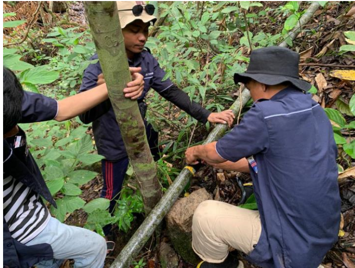
Gambar 3. Perbaikan pipa bocor
