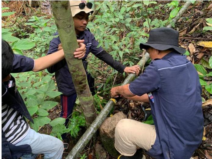
**Gambar 3.** Perbaikan pipa bocor
