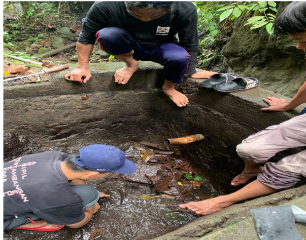
Gambar 2. Pembersihan sumber dan perpipaan air
