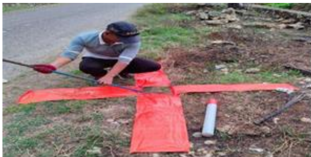
Gambar 2. Pemasangan Tugu GCP
