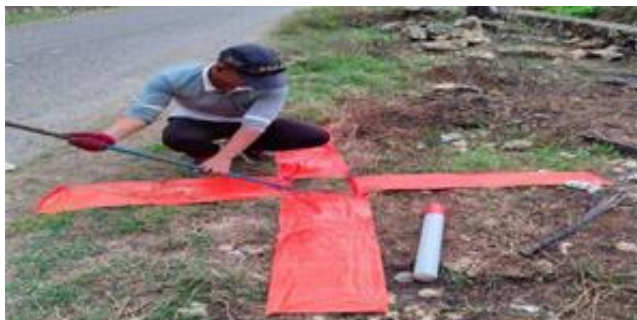
Gambar 2. Pemasangan Tugu GCP
